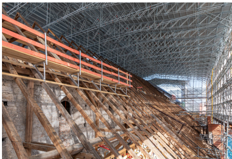
Freilegung des Dachstuhls Fotografie Dominik Fritz
