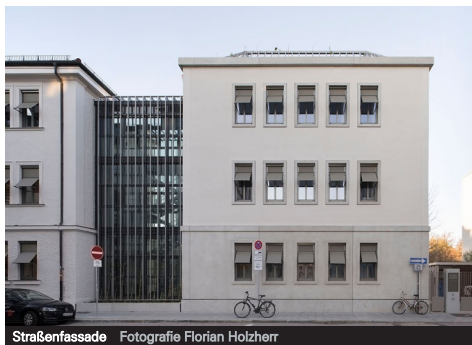
Straßenfassade Fotografie Florian Holzherr
