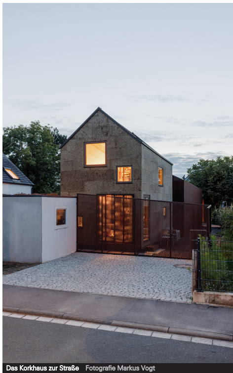
Das Korkhaus zur Straße Fotografie Markus Vogt
