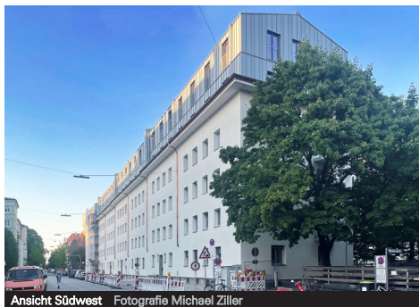
Ansicht Südwest Fotografie Michael Ziller
