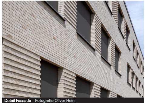
Detail Fassade Fotografie Oliver Heintl
