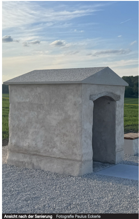
Ansicht nach der Sanierung Fotografie Paulus Eckerle
