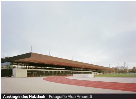
Auskragendes Holzdach Fotografie Aldo Amoretti
