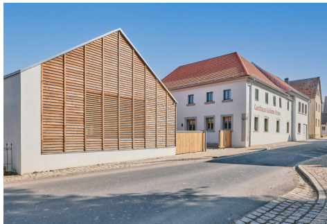
Straßenansicht Fotografie Benjamin Brückner
