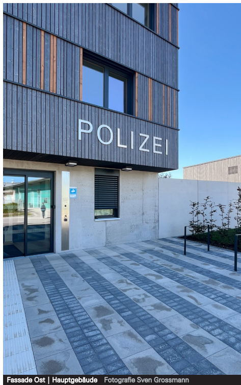
Fassade Ost | Hauptgebäude Fotografie Sven Grossmann
