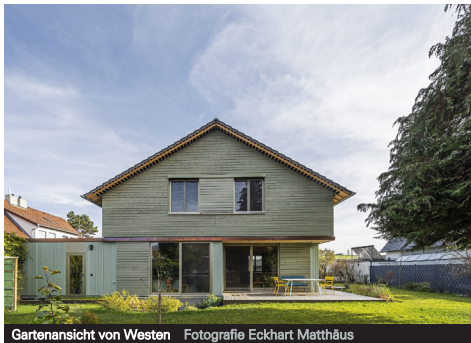
Gartenansicht von Westen Fotografie Eckhart Matthäus
