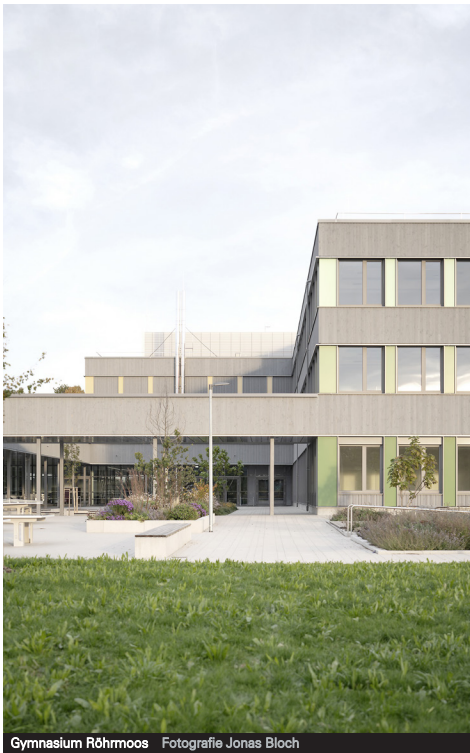
Gymnasium Röhrmoos Fotografie Jonas Bloch
