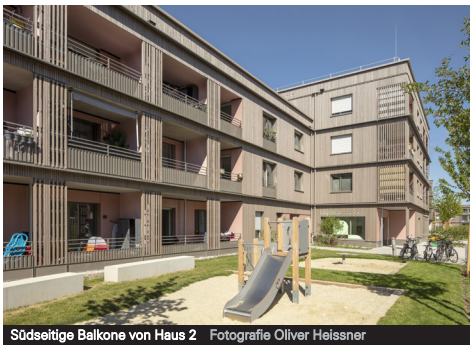
Südseitige Balkone von Haus 2 Fotografie Oliver Heissner
