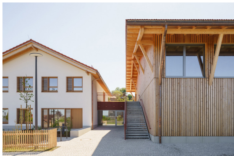
Zugang Turnhalle und Mittagsbetreuung Fotografie Sebastian Schels
