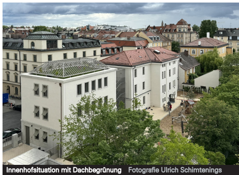
Innenhofsituation mit Dachbegrünung Fotografie Ulrich Schimtenings
