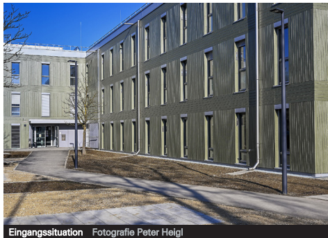
Eingangssituation Fotografie Peter Heigl
