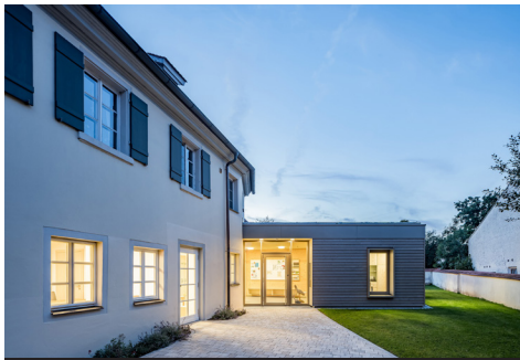
Baudenkmal und neuer Haupteingang Fotografie Maximilian Gottwald
