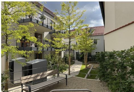
Innenhof mit Neubau 2 und Bestand 2 Fotografie Ferdinand Weber
