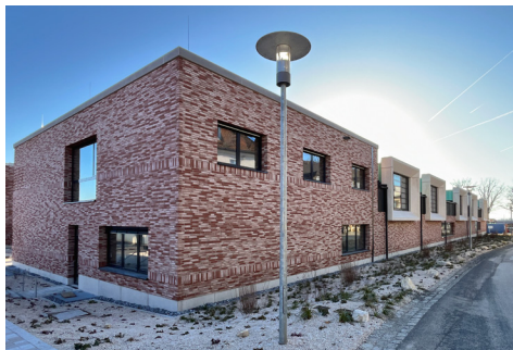
Verwaltungsbau mit Lehrhallen Fotografie Andreas Münzhuber
