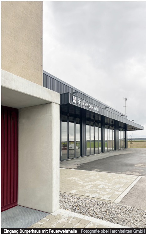
Eingang Bürgerhaus mit Feuerwehrhalle Fotografie obel I architekten GmbH
