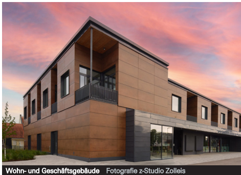
Wohn- und Geschäftsgebäude Fotografie z-Studio Zolleis
