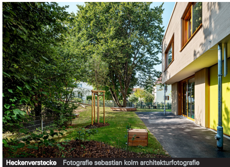
Heckenverstecke Fotografie sebastian kolm architektur fotografie
