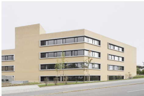
Ansicht von Süden (Hermann-Geib-Straße) Fotografie Brígida González
