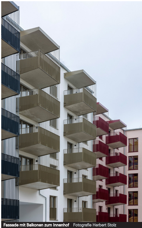
Fassade mit Balkonen zum Innenhof Fotografie Herbert Stolz
