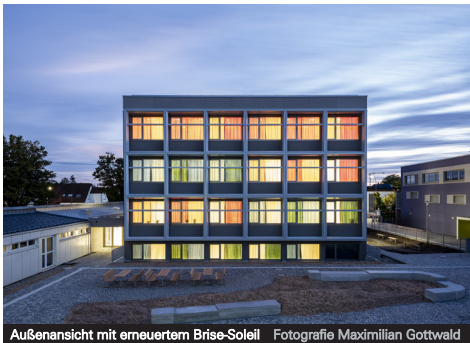
Außenansicht mit erneuertem Brise-Soleil Fotografie Maximilian Gottwald
