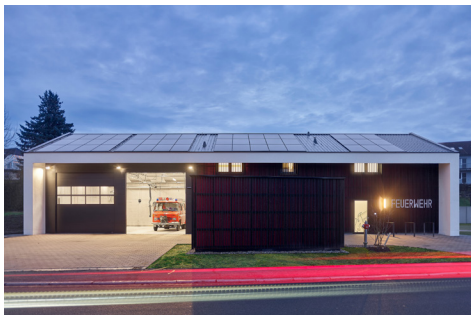
Nordfassade mit Ausfahrt + Haupteingang Fotografie Benjamin Brückner
