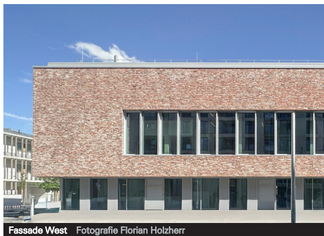
Fassade West Fotografie Florian Holzherr
