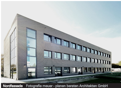
Nordfassade Fotografie meuer - planen beraten Architekten GmbH
