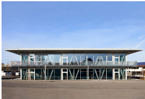
Bauteil E mit markanten V-Stützen Fotografie Nicolas Felder
